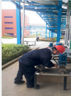
污水站泄漏现场应急处置演练
